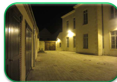
Restauration de bâtiment
