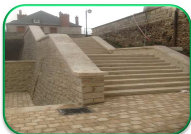
Réfection de maçonnerie
