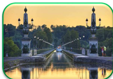
Restuaration d'ouvrage d'art
