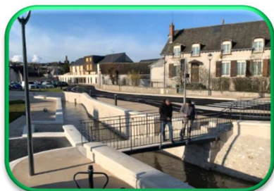
Voirie et réseaux divers
